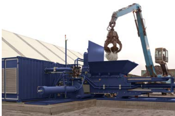
Installazione con impianto elettrico e idraulico nel container
